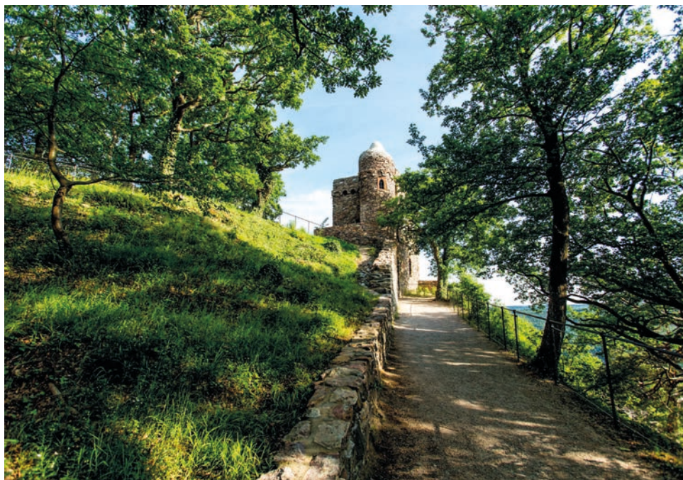
1 | Die Kunstruine Rossel – errichtet 1787 anstelle eines »Lustgewölbes« am höchsten Punkt des Osteinschen Niederwaldes – ist Teil einer programmatischen Reverenz des Mittelalters (Fotografie: Michael Leukel, 2018).
