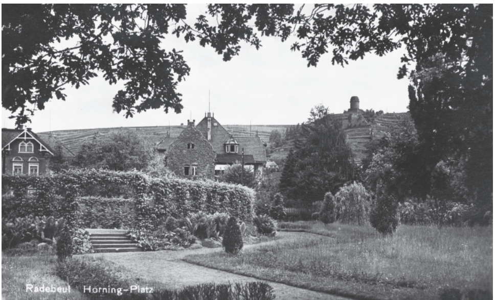
9 | Blick von Süden über den Hörningplatz, im Hintergrund der Bismarckturm und die Weinberge, Fotografie, um 1940 (Stadtarchiv Radebeul.-Bestand: Oberlößnitz.-Sign. R_062).
