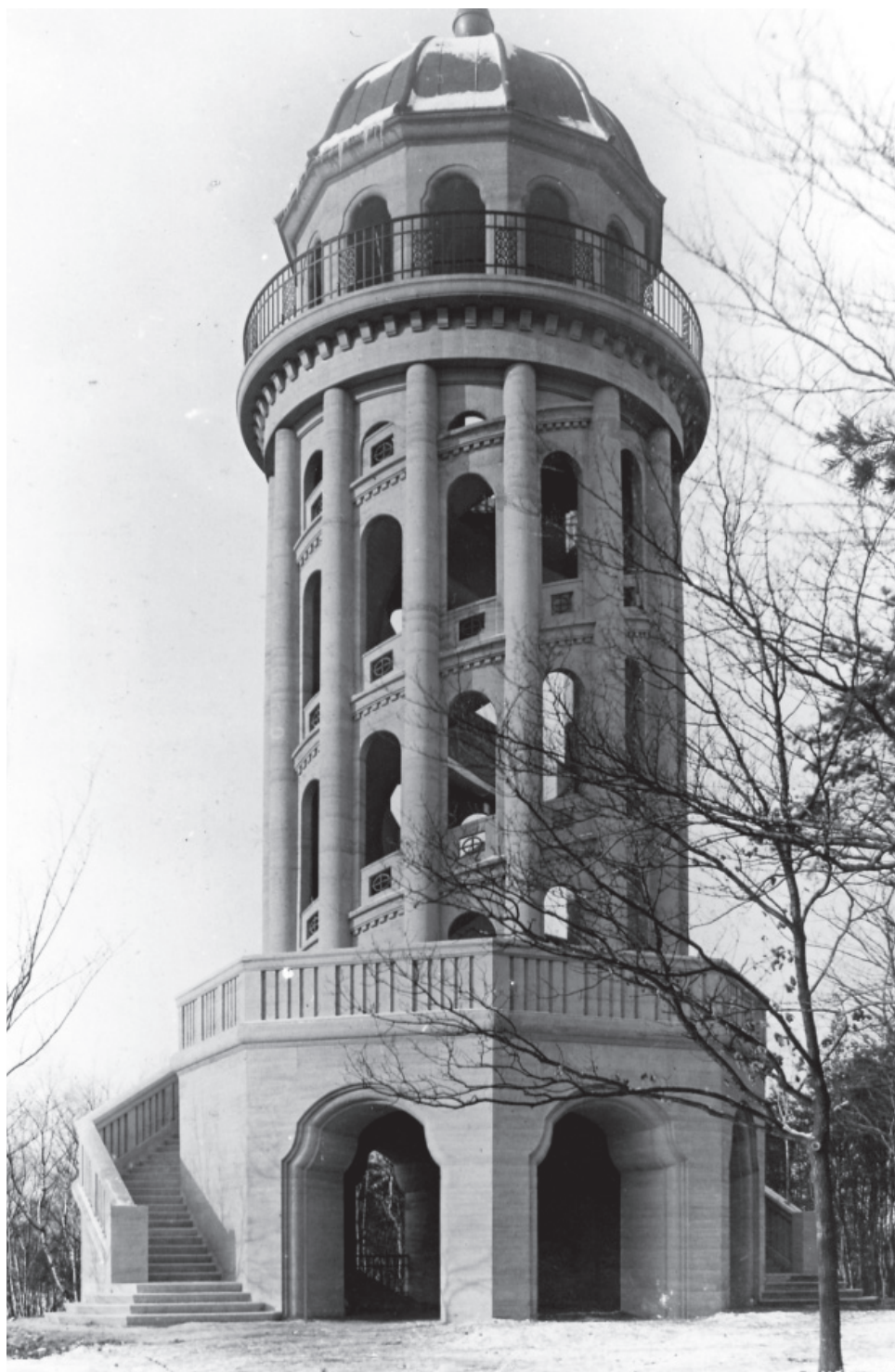
8 | Wolfshügelturm im König-Albert-Park. Ehemals als moderner Stahlbetonbau nach Plänen von Hans Erlwein 1911 erbaut, markierte er den höchsten Punkt des Geländes im Waldpark. Heute zeugen nur noch Trümmer von seiner Existenz (Bildstelle des Stadtplanungsamtes Dresden, Rp 9805 o. J.).
