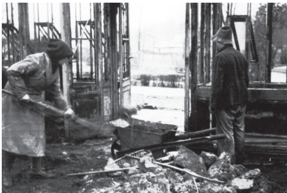
1 | Aufräumarbeiten im zerstörten Botanischen Garten, 1950 (TU Dresden, Botanischer Garten, Fotoarchiv).
