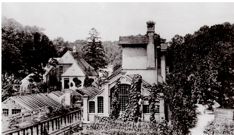
10 | »Orangenhaus« und Glashäuser im unteren Schweriner Küchengarten, Fotografie, um 1900 (LAKD M-V/LHAS, 13.2-1/1, Schwerin Grünhaus und Garten 10).
