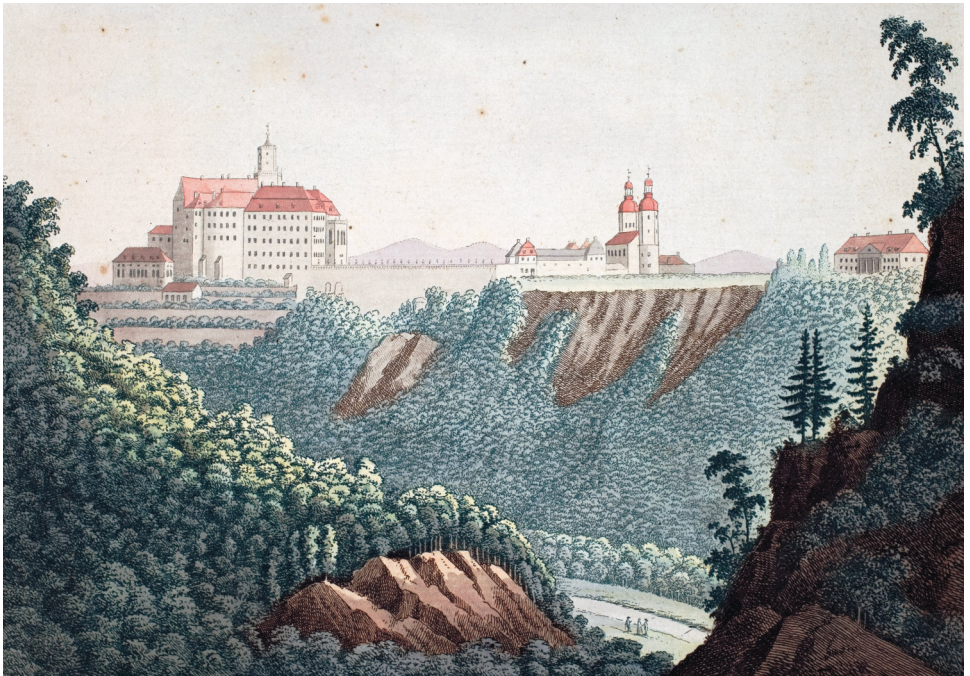
1 | Fürstenstein, Ansicht von Süden. Die Radierung zeigt eindrücklich den Naturraum, der die Fürstensteiner Anlagen umgibt: ein tief eingekerbtes Tal mit bewaldeten Hängen, schroffen Felsformationen und Wiesen in der Talsohle. Kolorierte Radierung, Friedrich Gottlob Endler (vermutlich nach eigener Zeichnung), um 1800 (Herder-Institut, Bildsammlung, Signatur P 4870).
